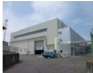
ERL開発棟(KEK) 旧東カウンターホール
